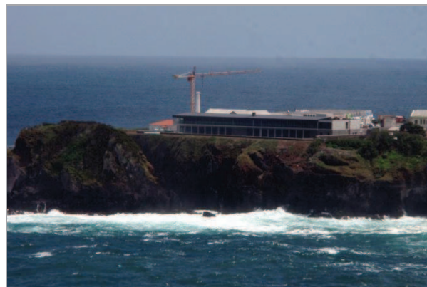
Hôtel 4 étoiles en construction à Santa Cruz das Flores face au littoral classé en zone protégée.
