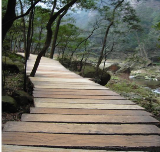
Photo N°14: Chemin en mortier façon bois
