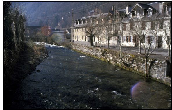
Photo 16 – Quai traditionnel en bordure de la Pique à Bagnères-de-Luchon (Haute-Garonne) (Cliché J.-M. Antoine, 1998)
