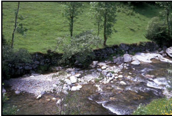
Photo 15 – Confortation de berges en bordure du Vicdessos au hameau de Ranet (Auzat, Ariège) (Cliché J.-M. Antoine, 1989)
