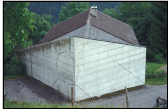
Photo 13 – Chalet contemporain protégé par une étrave maçonnée (Les Diablerets, Valais, Suisse) (Cliché J.-M. Antoine, 1997)
