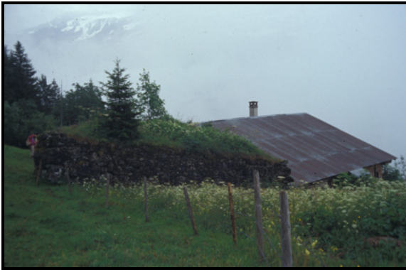
Photo 12 – Chalet d'alpage traditionnel protégé par une étrave à blocs cyclopéens (Les Diablerets, Valais, Suisse) (Cliché J.-M. Antoine, 1997)
