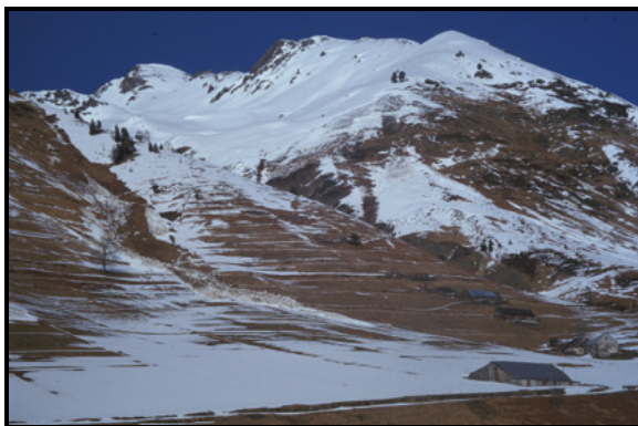
Photo 10 – Grange foraine munie d'un fort-tremplin face aux avalanches pulvérulentes (Barèges, Hautes-Pyrénées) (Cliché J.-M. Antoine, 2001)
