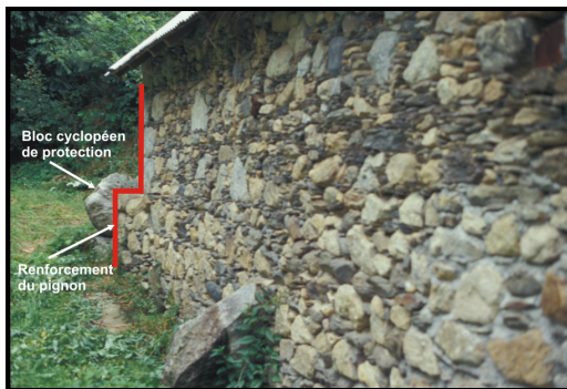
Photo 12 – Chalet d'alpage traditionnel protégé par une étrave à blocs cyclopéens (Les Diablerets, Valais, Suisse) (Cliché J.-M. Antoine, 1997)
