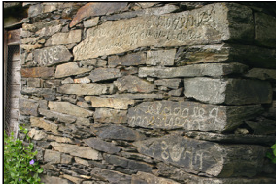
Photo 19 – Inscription commémorative sur une grange du hameau de Carol (Le Port, Ariège) « Cette avalanche a été détruite par l'avalanche de la Pelade le 9 mars de l'an 1877 » L'année 1882 portée à gauche est celle de la reconstruction du bâtiment. (Cliché J.-P. Métaillé, 1990)
