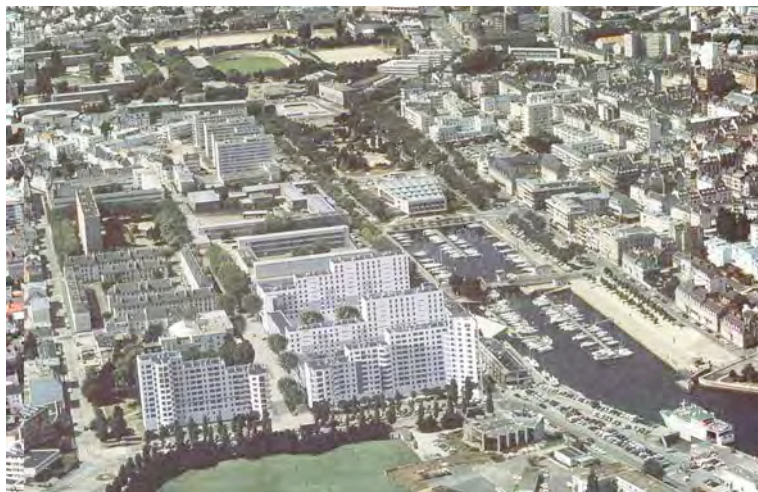
Le « remodelage » des immeubles des Quais de Rohan à Lorient 76 .
