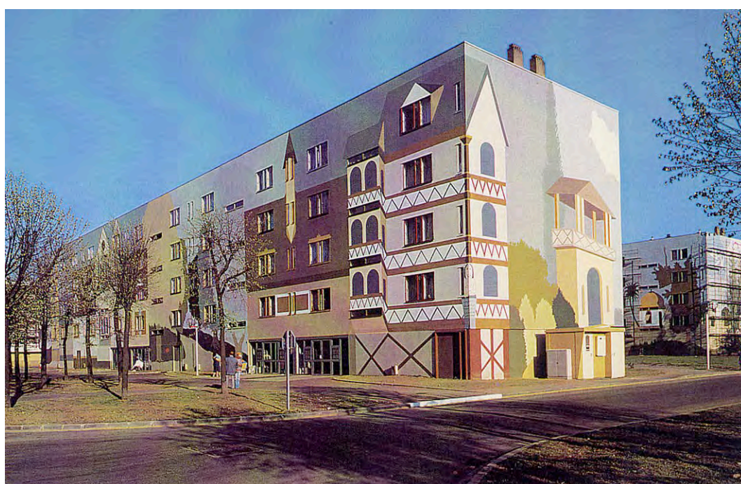
Réhabilitation des immeubles de logements sociaux de Thionville par Bernard LASSUS 110 .
