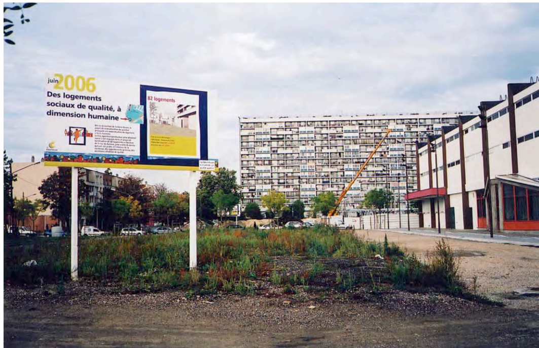
Emplacement de la barre Renoir démolie en 2000 214 .
