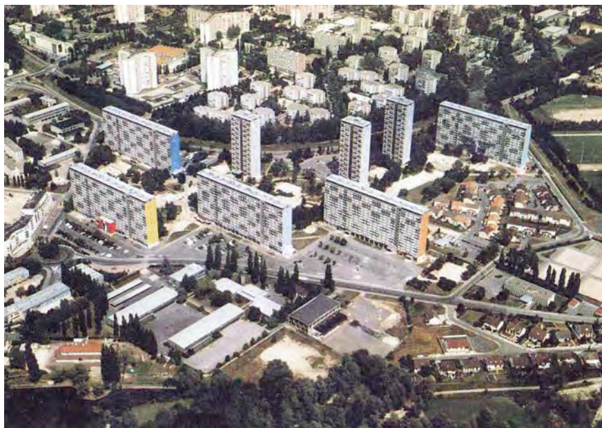
Ensemble de la Pierre Collinet. Réalisation des pavillons du « Bouquet d'Eglantine 161 ».
