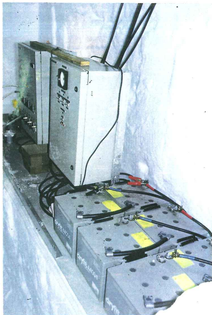
Figure 1.7. : vue de l'intérieur de notre tranchée.
