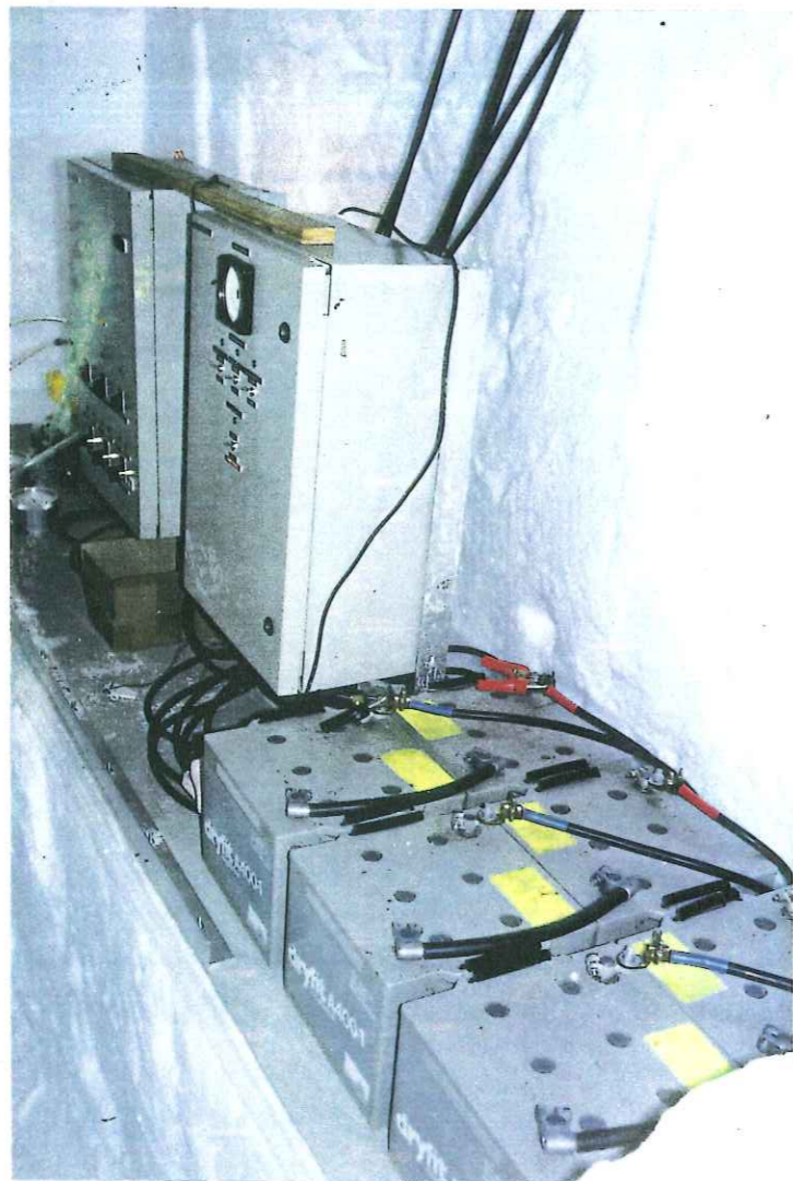
Figure 1.7. : vue de l'intérieur de notre tranchée.
