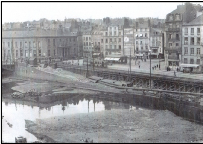
Photo 18 : Les travaux de comblement du bras nord de la Loire en bordure de la place du commerce (Source : Archives Municipales de Nantes-13FI13656)
