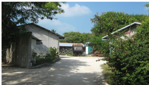
...à proximité de locaux techniques
