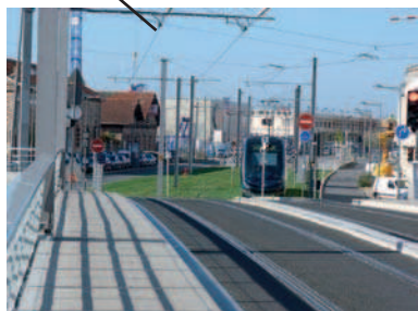
Le franchissement des Bassins à flot par le pont tournant menant à Bacalan.
