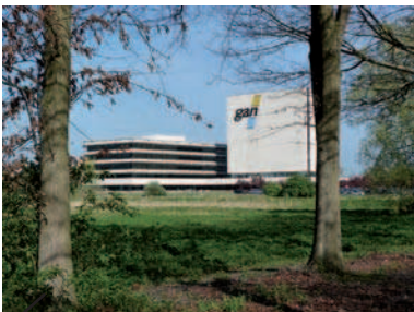
Le secteur du Lac est un pôle tertiaire majeur de l'agglomération. Ici, les bureaux de l'entreprise GAN.
