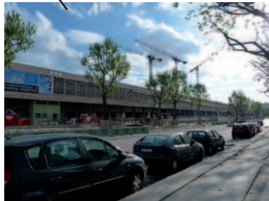
La façade nord de l'entrepôt Macdonald, boulevard Macdonald.
