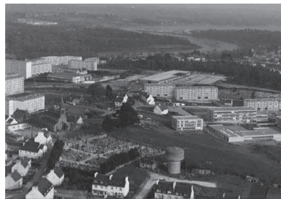
En 1962, ce site de la ZUP de Kermoyan est retenu parce qu'il constitue une zone relativement déserte de la banlieue quimpéroise. Au second plan, les premiers immeubles de la ZUP. Source : Mairie de Quimper, 1963.
