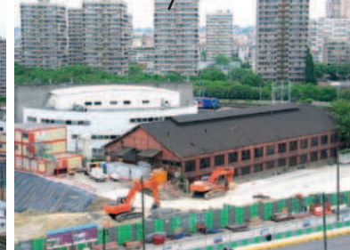
Le terrain triangulaire compris entre la rue d'Aubervilliers, les faisceaux ferroviaires de la Petite Ceinture et de la Gare de l'Est. Ce terrain est également appelé « Triangle Éole Évangile ».
