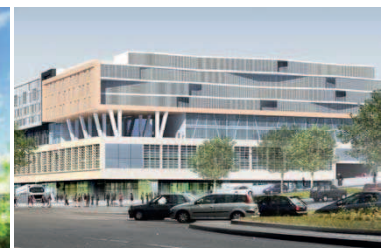
O1 - Ch. De Portzamparc - 78 logements sociaux
