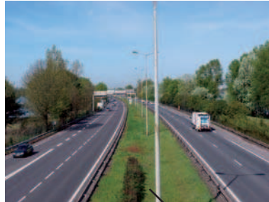
La rocade de contournement de Bordeaux, autoroute A630.
