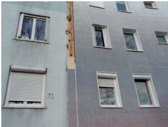
Le Serpentin retrouve des couleurs en 2009 après que les appartements aient été rénovés et l'isolation extérieure refaite. Source Chapitre : www.batiactu.com/ , consulté le 28 octobre 2011.
