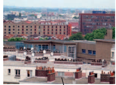
Les Entrepôts et magasins généraux de Paris (EMGP) vus depuis le toit de l'entrepôt Ney.
