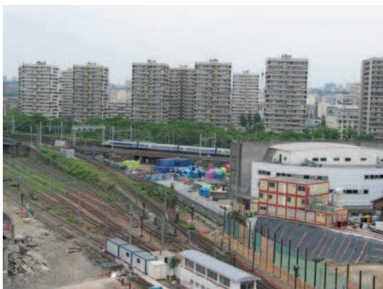
La Cité Michélet, un des plus grands ensembles construit à la fin des années 1970 à Paris comptant 16 tours de 18 étages et un bâtiment barre de 8 étages, accueillant au total près de 1 800 logements. Source : A. Taburet, 2011.
