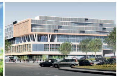
O1 - Ch. De Portzamparc - 78 logements sociaux
