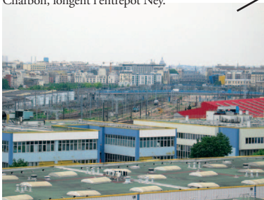
Zone d'activités CAP 18 et les faisceaux ferroviaires de la Gare de l'Est.
