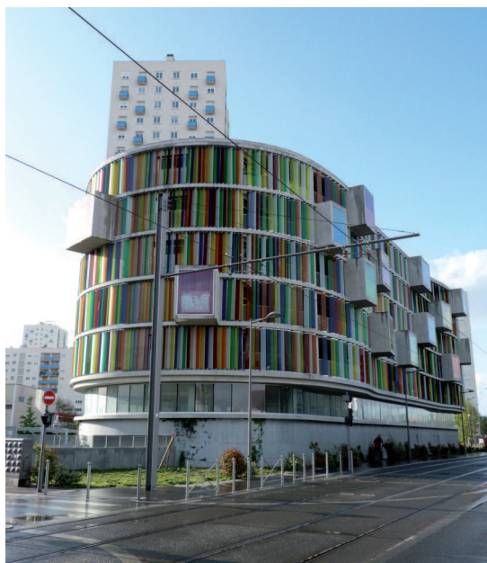
À Bordeaux, la résidence Arc-en-Ciel, conçue et livrée par l'architecte Bernard Bühler en 2010, illustre la rupture architecturale et conceptuelle d'avec ses prédécesseurs à l'arrière-plan. La résidence compte 40 logements locatifs sociaux et des bureaux. Source : A. Taburet, 2012.
