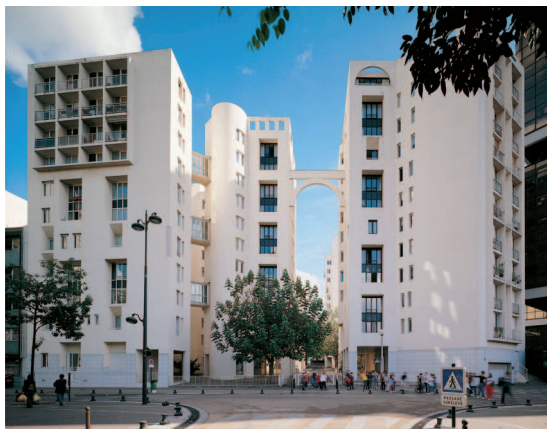
Les Hautes Formes, résidence livrée en 1979 à Paris. Ce petit ensemble d'habitat social, dont les 209 logements s'inscrivent autour d'une rue, d'une place et de cours, rompt avec la brutalité de l'urbanisme vertical. Source : J.-M. Monthiers/ADAGP, 2009.
