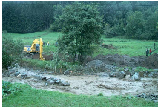
FIG. 1.4: Création de digues à partir des matériaux charriés pour canaliser le lit en fin d'après-midi
