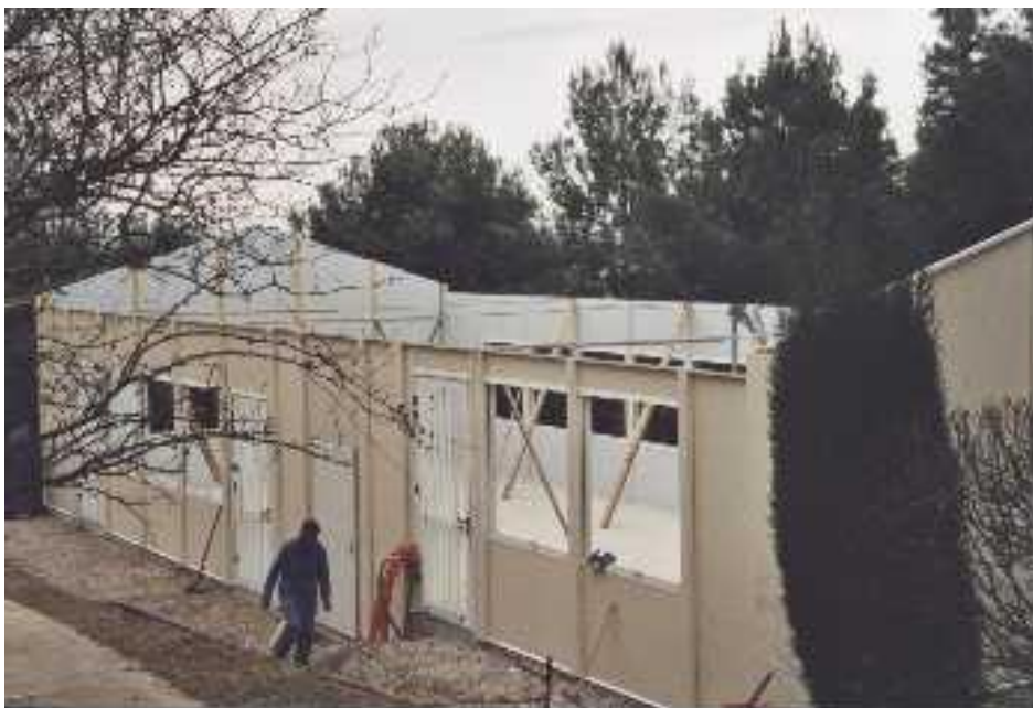
Photo n° 8 : Les nouveaux bâtiments en construction à Perpignan (2001)
