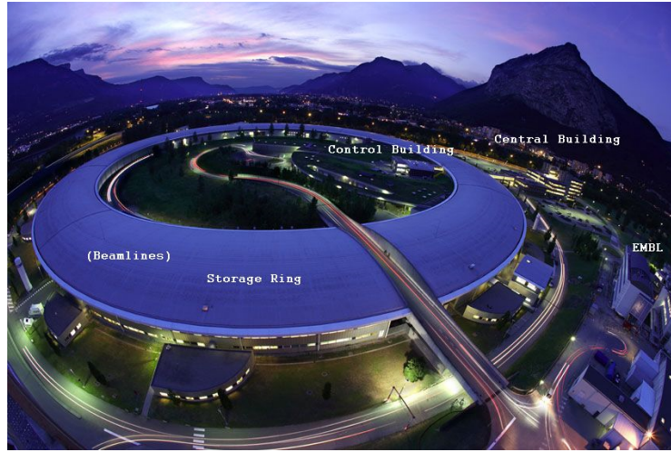
FIGURE 4.6 – Photographie du synchrotron de Grenoble. On peut voir l’anneau de stockage d’environ 320 m de diamètre dans lequel sont accélérés des électrons afin de produire les rayonnements X.
