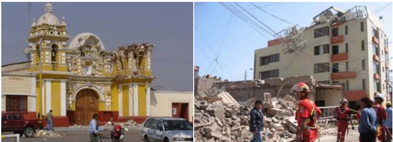
Photos n°16 et 17 : Eglise de Chincha suite au séisme de Pisco en 2007 ; dommages aux édifices et aux infrastructures de télécommunications dans le centre de la ville de Pisco.
