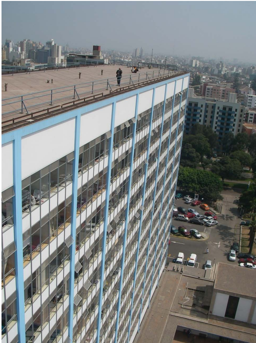
Mesures de vulnérabilité du bâti sur le toit de l'hôpital Rebagliati (Essalud), 14 étages, 1500 lits, le plus grand de Lima (J. Robert, 2010)
