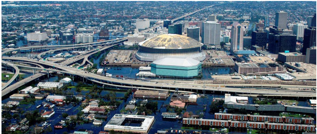
Photo n°3 : Le Superdome et la ville inondée
