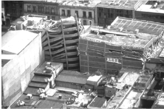
Photo n°2 : Séisme de 1985 à Mexico : effondrement vertical d'un immeuble Source : Boise State University (in Mancebo, 2006a)
