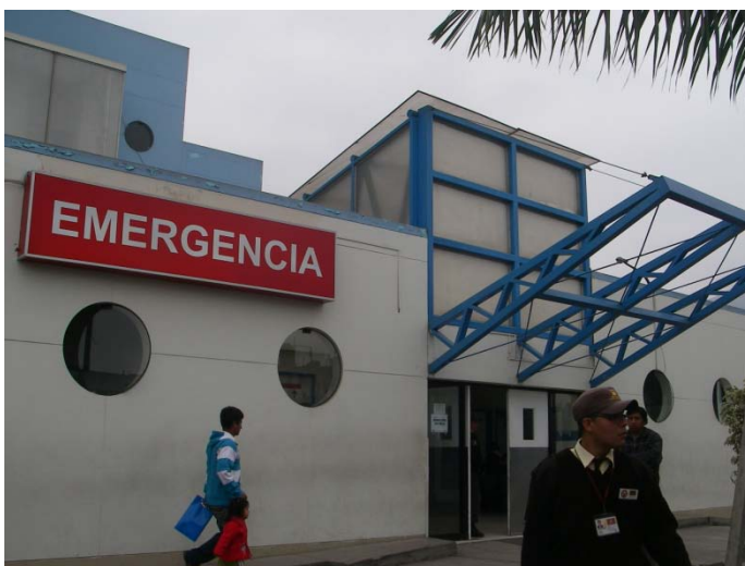
Photos n°35 et 36 : Hôpital des forces de Police et les urgences du récent hôpital Marino Molina (EsSalud) Source : J. Robert, 2010
