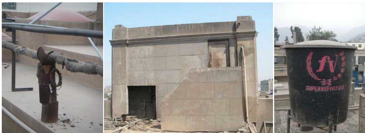
Photos n°53, 54 et 55 : Canalisation soutenues de façon précaire au Sabogal (EsSalud) ; réservoirs d'eau en dur pour le Loyaza et réservoirs plus légers pour le Sergio Bernales (Minsa). Source : J. Robert, 2010
