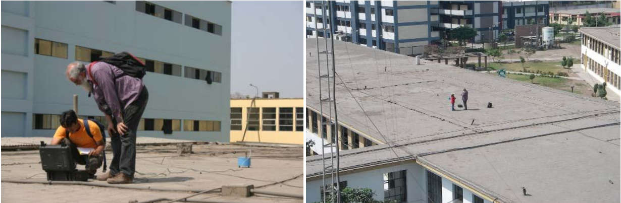
Photos n°49 et 50 : Mesures sur le toit de l'hôpital Dos de Mayo et sur celui de l'Hipolito Unanue
