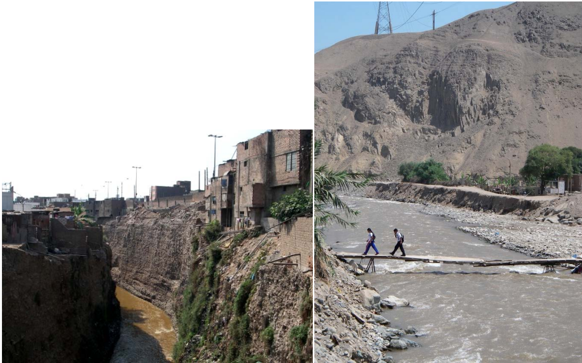
Photos n°65 et 66 : Le río Rímac formant un véritable obstacle entre le Cercado de Lima et San Martín de Porres ; seulement trois ponts permettent de traverser le río Chillón en voiture au nord de l'agglomération Source : J. Robert, 2009
