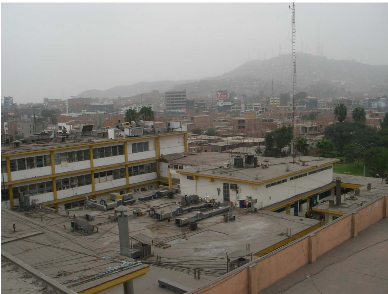
Photo n°56 : Complexité du fonctionnement des hôpitaux : systèmes d'aération, de télécommunications et réservoirs d'eau sur les toits de l'hôpital Cayetano Heredia
