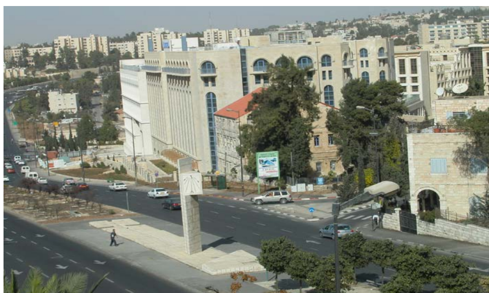
Figure 52 : Recouvrement de la ligne verte, route n°1, à Jérusalem-Est en direction de Ramallah L'immeuble ancien mitoyen à l'hôtel était occupé par l'Unwra jusque dans les années 70. En arrière plan, les quartiers de French Hill. Image : G. Dupin (2003)
