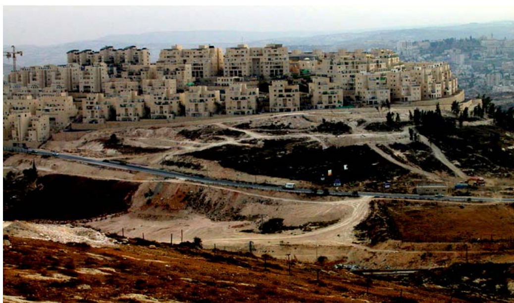
Figure 47 : Implantation récente de Har Homa en 2000 à l'entrée de Bethléem Au premier plan, la barrière de sécurité en chantier. A l'arrière plan, Bethléem. Image : G. Dupin (2003)
