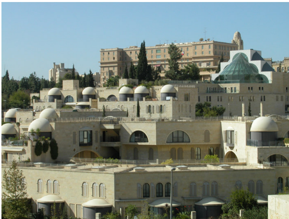
Figure 53 : La résidence du Village de David Ici vue en contrebas de l'hôtel du King David et de l'administration Sioniste Mondiale (toiture en verre) Image : G. Dupin (2003)
