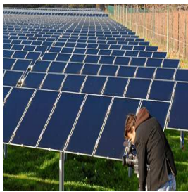
(a) Ferme photovoltaïque. Source : www.energiegratuite.biz
