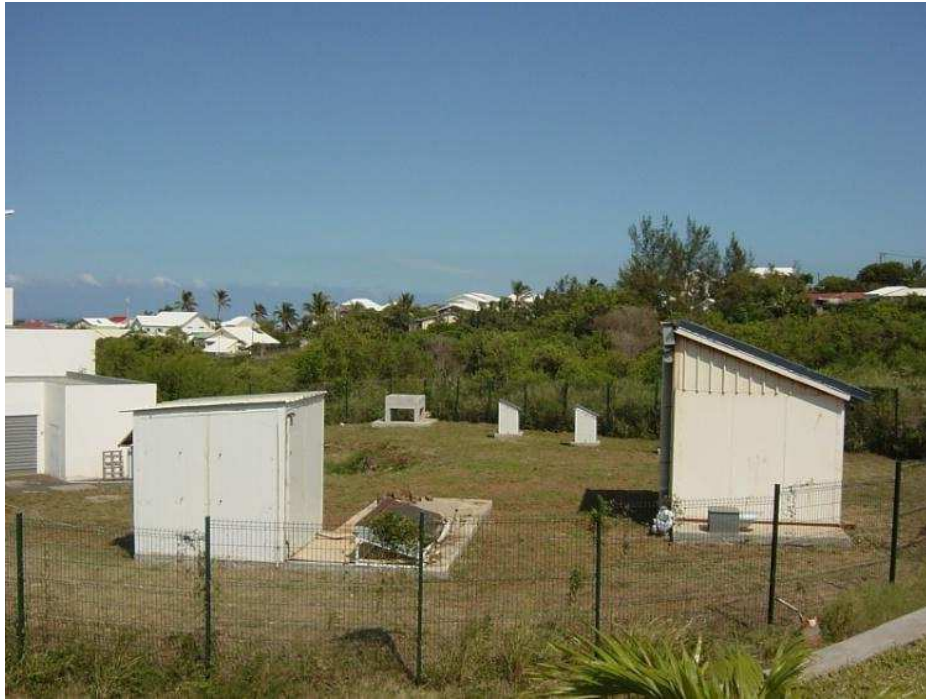
FIGURE III.1 : Vue d'ensemble de la plateforme expérimentale de l'IUT de Saint-Pierre (La Réunion).
