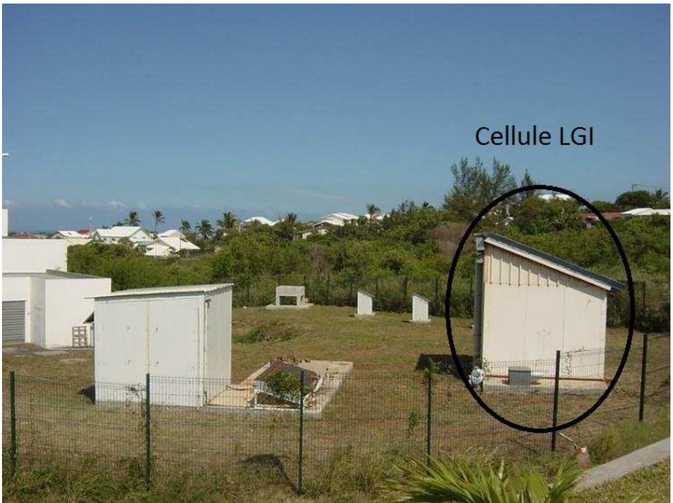
FIGURE IV.44 : Vue de la plateforme expérimentale avec la LGI à droite.
