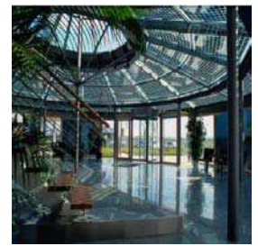
(d) Verrière photovoltaïque. Source : ADEME
