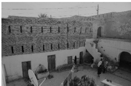
Vue vers la pièce 8, la sgifa et l'escalier
