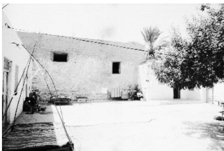
Vue de la cour, à gauche les pièces 3 et 4
