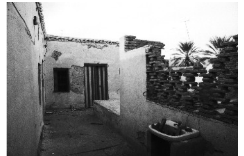
Vue de la pièce 13, à l'étage
