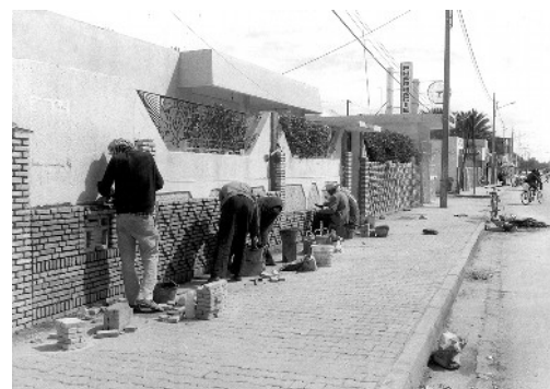
Ill. 11: les travaux d'embellissement des façades et clôtures
