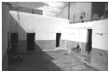
Vue de la cour vers l'entrée, la sgīfa et la pièce 3
