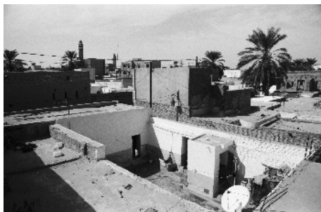
Vue de la cour par les toits mitoyens
