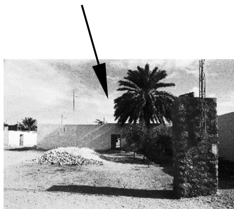
Vue de l'entrée, à partir du terrain ḥawz 12
