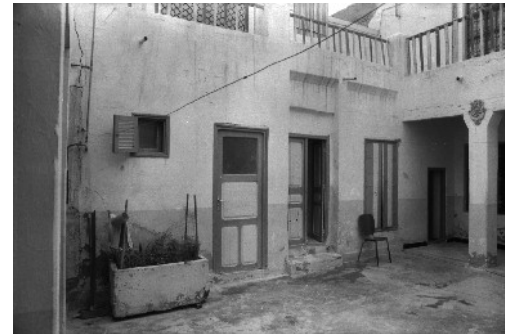
III. 55: vue de la cour vers la porte de la pièce d'eau et l'escalier
