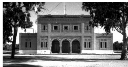
Ill. 3: la gare de Tozeur, construite en 1913
