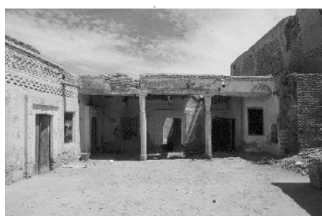
Vue vers le portique 12 et les pièces 7 et 10
