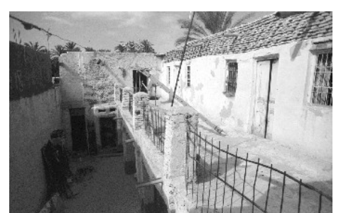
Vue de la terrasse à l'étage
