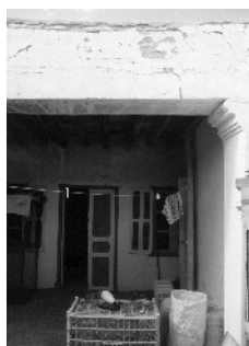
H3-B : la terrasse 15 vers la pièce 7
