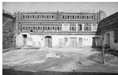
Ill. 6: vue intérieure d'une habitation, quartier d'El Hawadef
