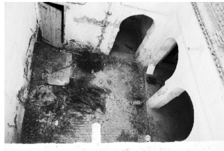
Vue de la cour, à partir de l'étage
