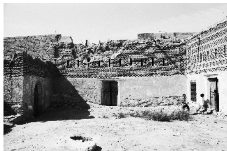
Façade de la pièce 4, à gauche la sgifa 2
