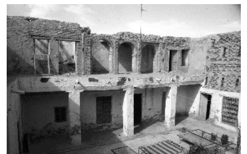
Vue vers la pièce 4, à l'étage les pièces 12-17
