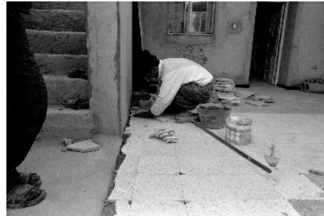
Revêtement du sol de 2 (à gauche : escalier 8)
