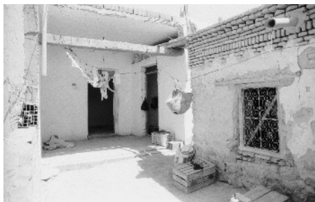
Vue vers la véranda, à droite la pièce 3
