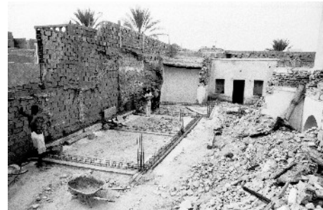
Chantier de rénovation des pièces 4 et 7 (2000)
