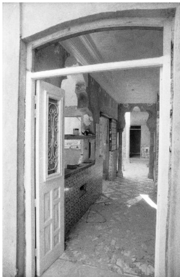
Vue du hall 2, vers la pièce 4
