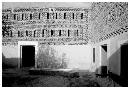
Extérieur des pièces 4 et 5, vue de la cour
