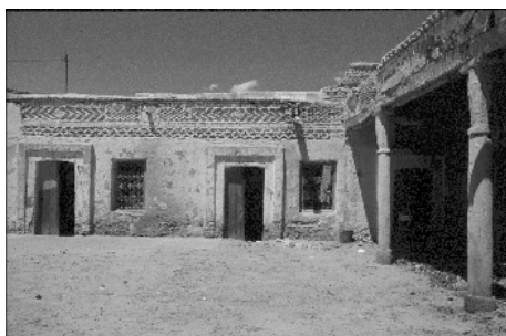
Vue vers les pièces 4 et 5, à gauche le portique
