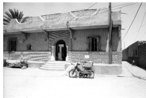
III. 158: façade avant de H4, vue de la placette
