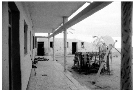
Vue de la cour, sous la véranda
