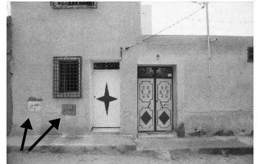
III. 211: deux compteurs d'eau pour une même entrée, quartier de Chabbiyya, 1998
