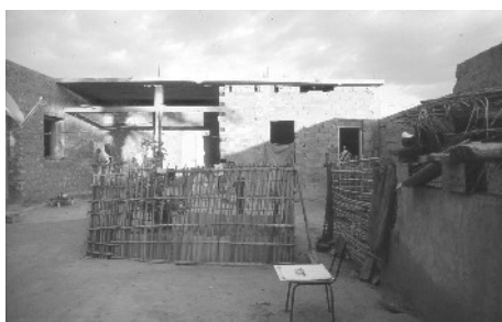
Vue de la cour, vers l'entrée et la cuisine
