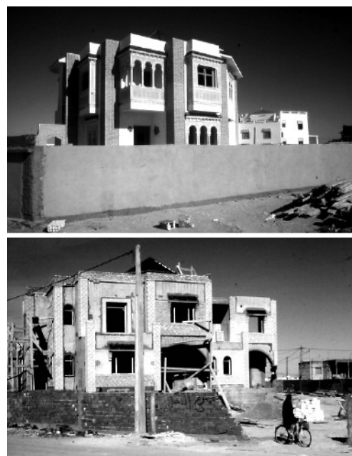
III. 234: deux « châteaux » en cours de construction en 1998, lotissement Chebbi II
