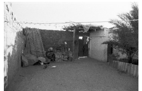
La cour, vers la porte d'entrée et la cuisine 3
