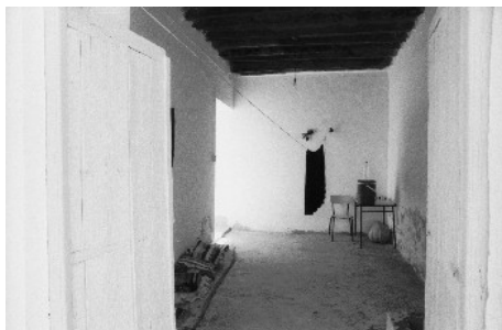
Vue de la sgifa d'entrée, à partir de la rue
