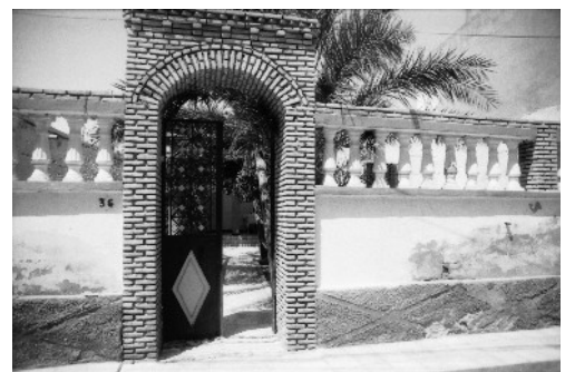
Ill. 136: le mur de clôture de Bled El Hadhar H6
