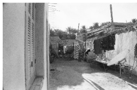
Vue vers les pièces 4 et 5, démolies en achèvement des pièces 6 (photo 2001)
