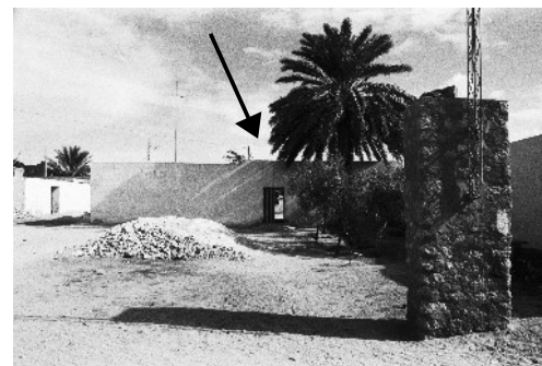
III. 170: vue de l'entrée, à travers le hawz
