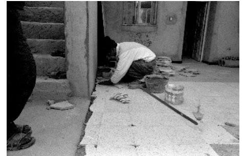
Revêtement du sol de 2 (à gauche : escalier 8)
