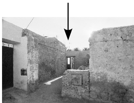
Vue de l'entrée par l'impasse (photo 2001)
