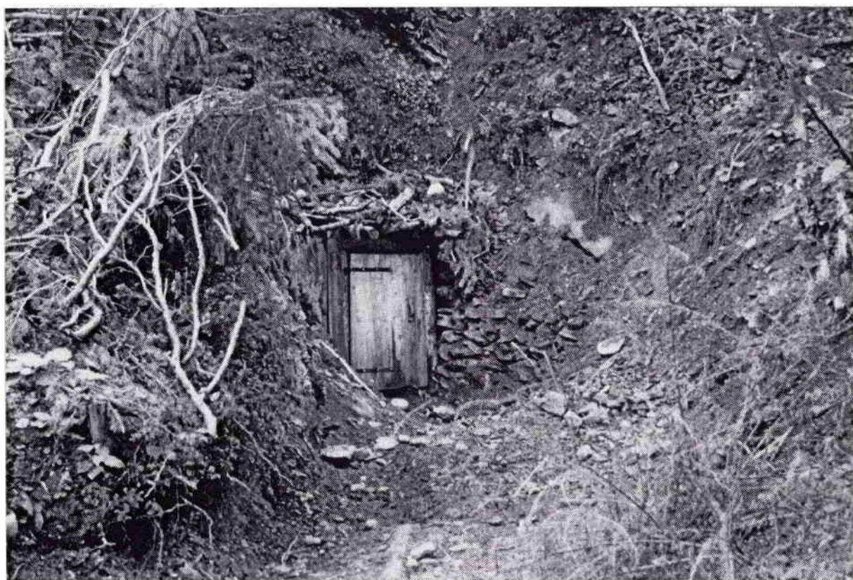
1. Entrée de la charbonnière restaurée de la Cabane, Grande Concession, Villard-Saint-Pancrace (photo J.L.T., 1991)
