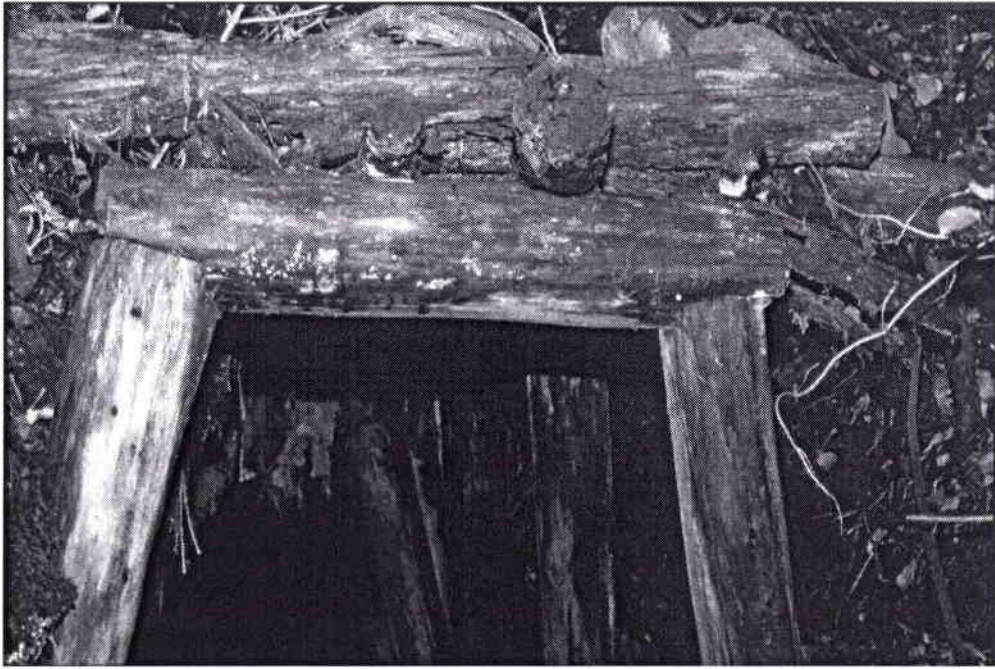
4. Premier cadre (piles et chapeau) et garnissage dans une charbonnière de Villard-Saint-Panrace (photo J.L.T., 1991)
