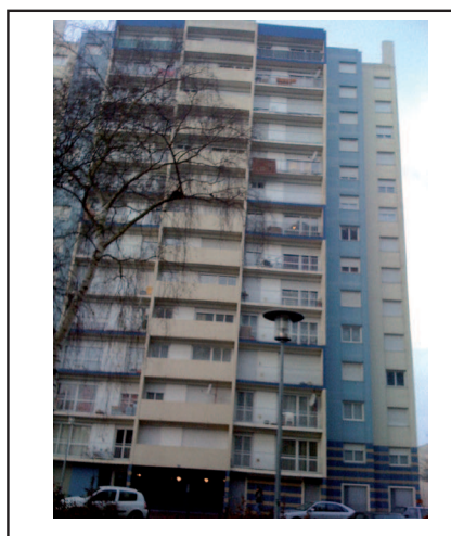
Photo 14. Vue du nouveau bâtiment de Gisèle. Tour Gaubert (Belle Beille). Angers
