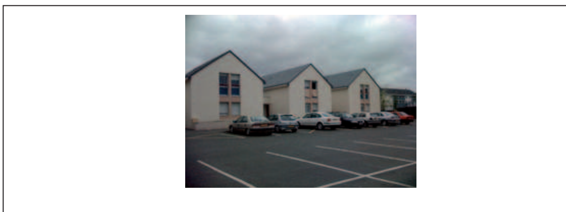
Photo 18. Vue du nouveau logement de Claire. Square Vélodrome (Belle Beille). Angers
