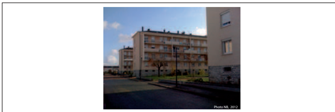
Photo 32. Vue du nouveau bâtiment de Chantal. Rue A. Chevrollier (Les Plaines). Trélazé
