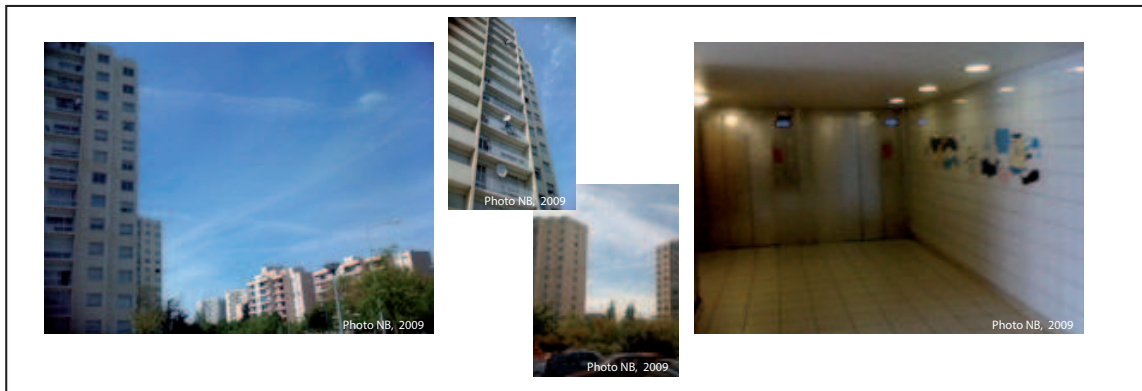
Photo 24. Vue du nouveau bâtiment de Diwani. Square Dumont d'Urville (La Roseraie). Angers
