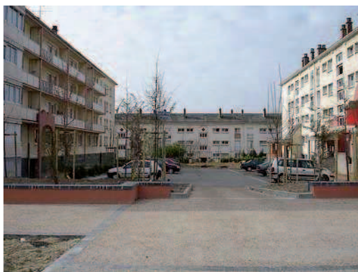
Photo 5. La résidentialisation (pose des murets)
