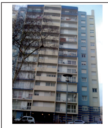
Photo 14. Vue du nouveau bâtiment de Gisèle. Tour Gaubert (Belle Beille). Angers
