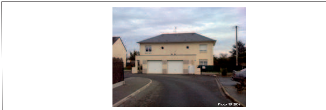
Photo 35. Vue de la maison de Mohamed et Fatima. Rue F. Cauchet (Gare). Trélazé
