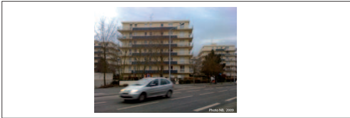
Photo 36. Vue du nouveau bâtiment d'Annie. Chemin de Toucheronde (Les Justices). Angers
