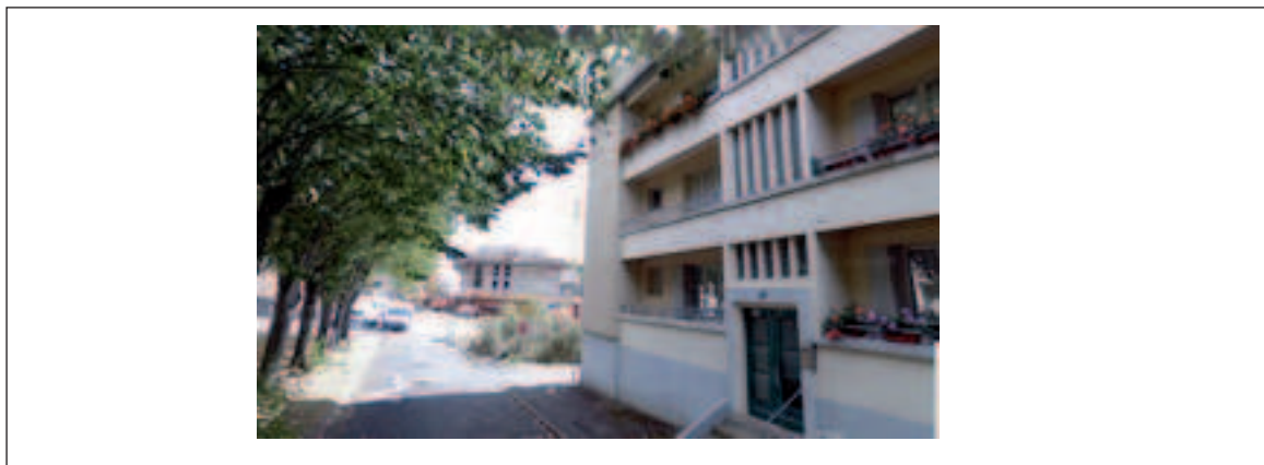
Photo 12. Vue bâtiment d'Armand. Avenue Patton (Belle Beille). Angers
