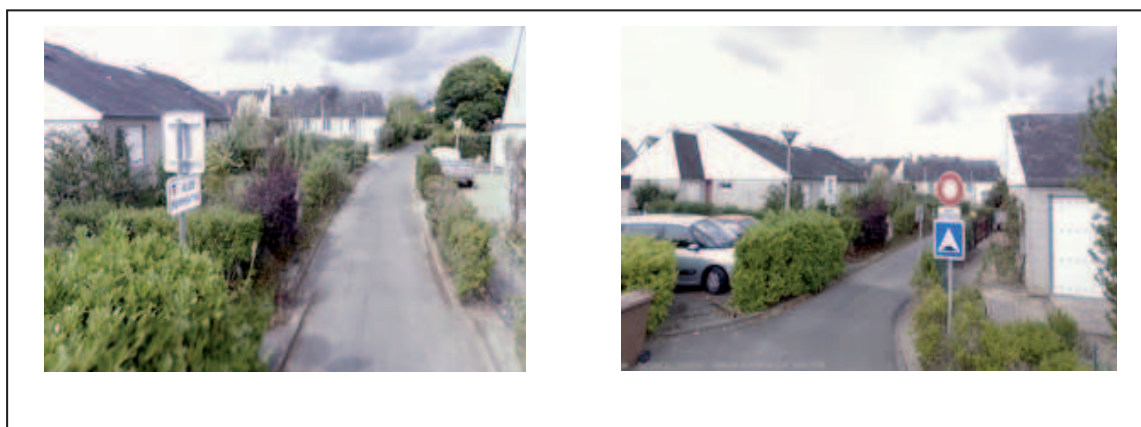
Photo 23. Vue de la nouvelle rue de Maria. Allée serpentine (La Roseraie), Angers.
