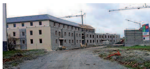
Photo 4. Réalisation de nouveaux immeubles d'habitat social sur l'avenue M. France, Trélazé
