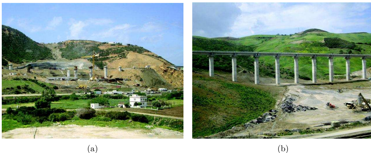
Photo IV.1 – Construction de l'autoroute entre Tanger-Med, Tanger-Ville et Casablanca, avril 2008. Photos N. Mareï.
