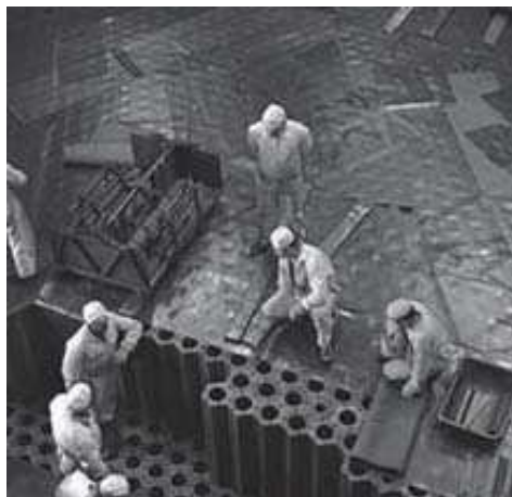
Figure 3 : Construction des empilements de graphites
