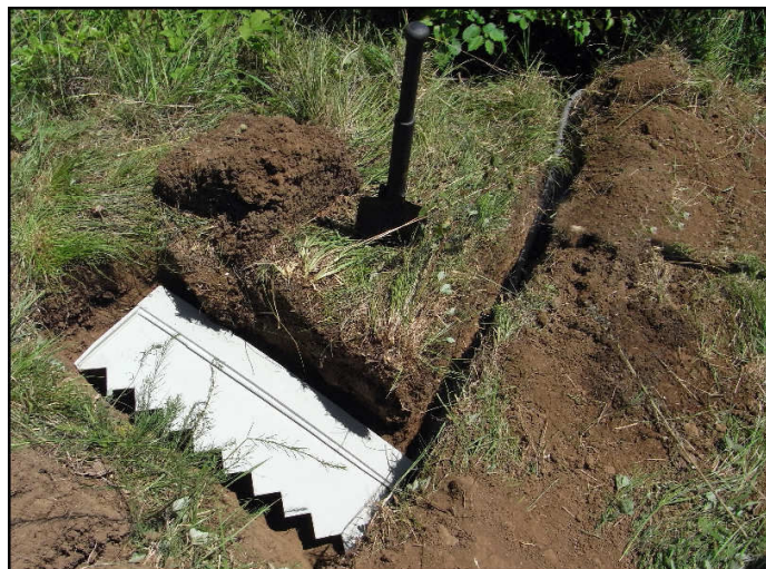
Figure 2.5 : Photo de l'installation d'une plaque lysimétrique.
