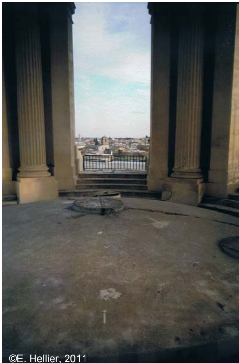
3 - Réservoir du Peyrou à Montpellier
