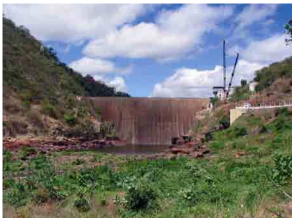
Mur du barrage Mãe d'Água
