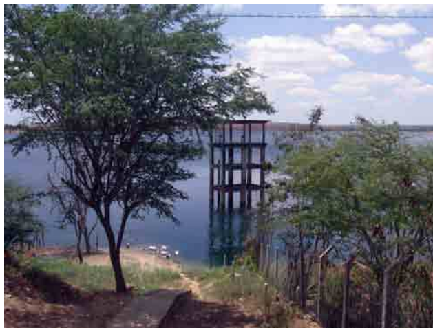
Figure 37 : Lac du barrage Epitacio Pessoa avec la tour de la prise d'alimentation en eau
