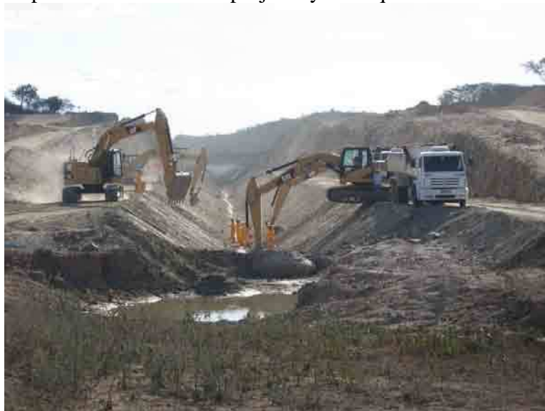
Figure 40 : Travaux de creusement du canal du São Francisco en août 2010
