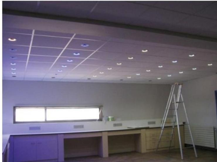
Figure 122 : Installation des luminaires Luxspaces équipés des différents disques de luminophores à tester
