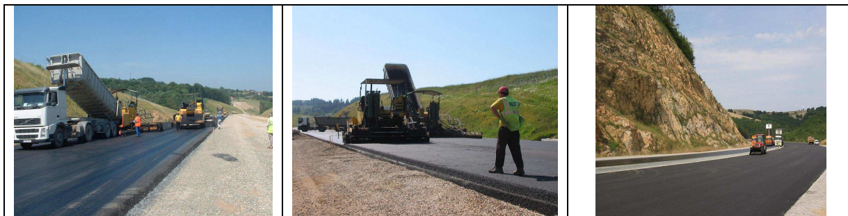
Figure 42 : Travaux de chaussée
