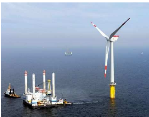
FIG. 1.3: Mise en place d'une éolienne offshore (Source : Dredging International).
