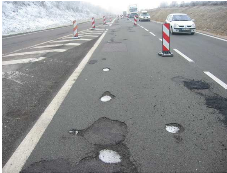
FIGURE 1.11 – Séries de nid de poule dans les bandes de roulement [Mauduit et al., 2007]
