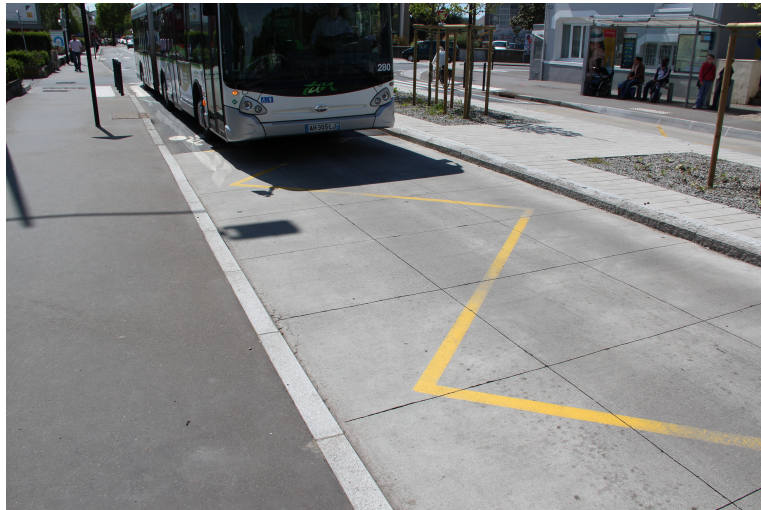
FIGURE 1.8 – Chaussée BCMC - Arrêt de Plessis Tison, Bd Jules Verne, Nantes, France
