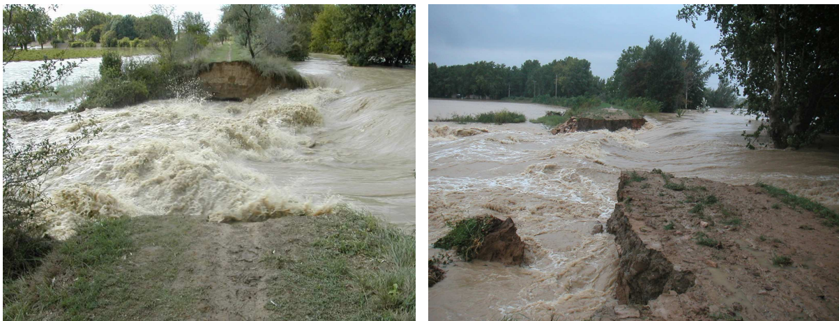
Figure 10. Cas de rupture par surverse sur le Vidourle, Gard, 2002 (Source Cemagref)
