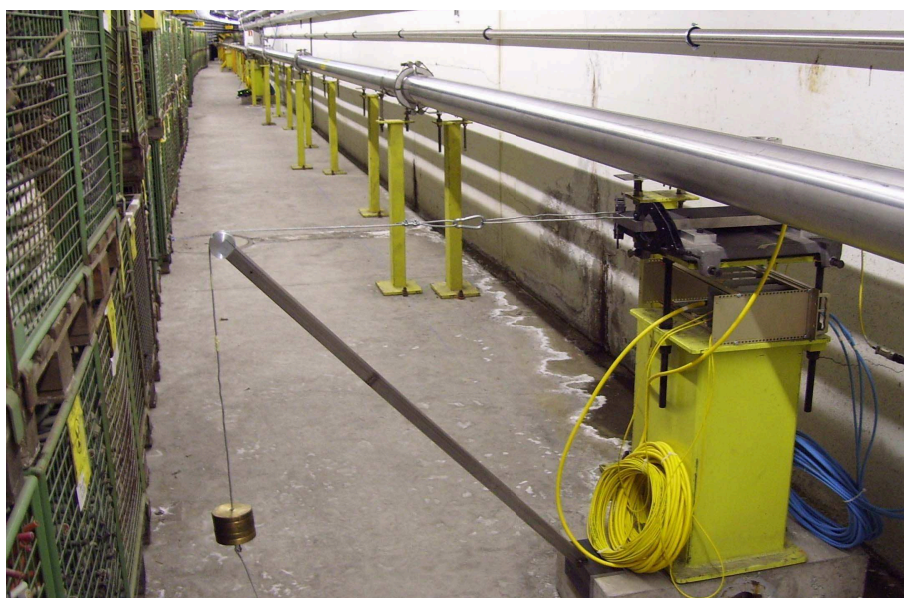
FIG. 4.8 – Tests de déplacements transversaux des plaques invar
