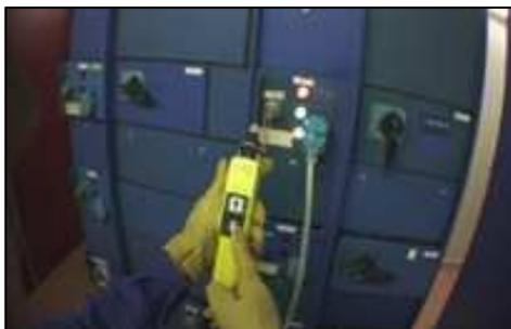
Le robinet se pilote par l'intermédiaire d'une boîte à boutons que l'opérateur vient brancher sur le système après avoir remis en conformité d'exploitation la cellule électrique de commande.
