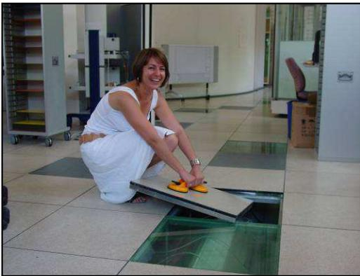
Figure 19 : LDC : dalles du plancher technique
