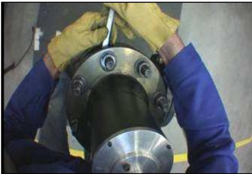
Changement d'un joint et remise en fonction d'un assemblage boulonné sur une vanne.
