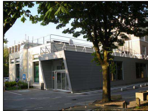
Figure 18 : LDC : vue de l'extérieur
