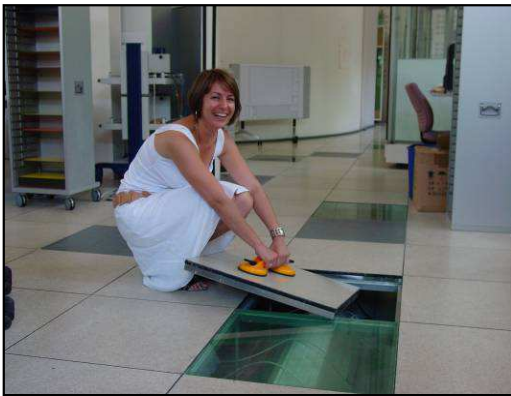
Figure 19 : LDC : dalles du plancher technique
