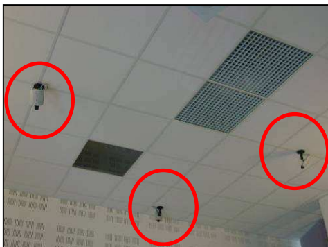
Figure 25 : Offsats au plafond
