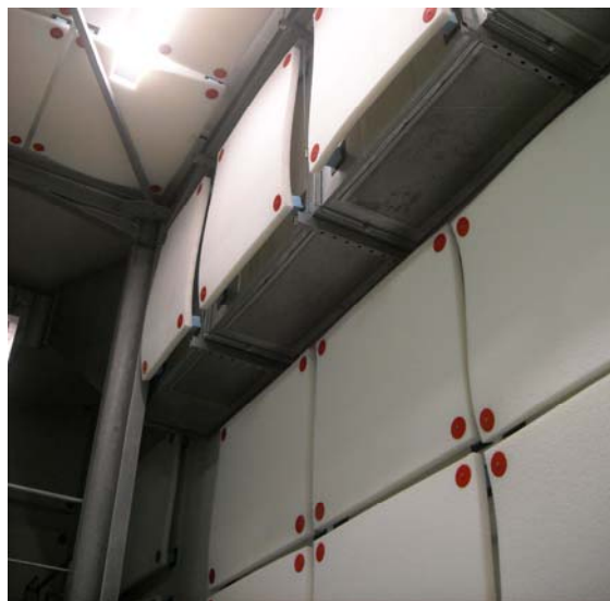
Figure 4.15. Aperçu des parois traitées de la salle utilisée pour les mesures acoustiques.
