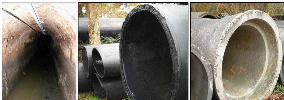
**Figure I-7 : Photographies de canalisations de réseaux d'assainissement réalisées à partir de différents matériaux (pierre, polymère, béton).**
