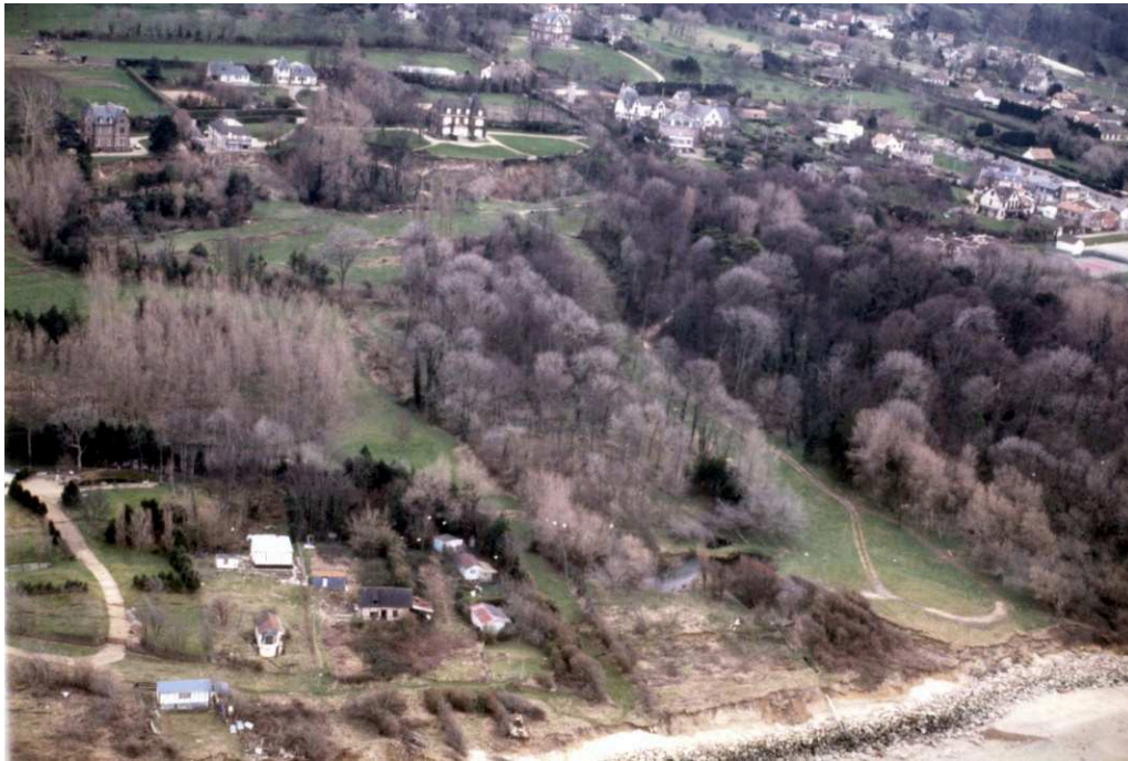
Figure 2-24. Vue aérienne des Fosses du Macre suite à l'accélération de février 1988 avec à l'arrière plan l'escarpement principal et au premier plan, de nombreuses factures ouvertes (chemin à gauche).
