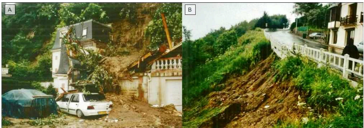
Figure 1-5. Glissements de terrain sur la commune de Trouville-sur-Mer déclenchés suite aux orages du 1 er juin 2003 (source : Lebre, 2003). (A) Glissement au lieu-dit "Les Creuniers", en amont du glissement de Hennequeville, (B) Glissement superficiel déclenché à l'est du glissement du Chant des Oiseaux.
