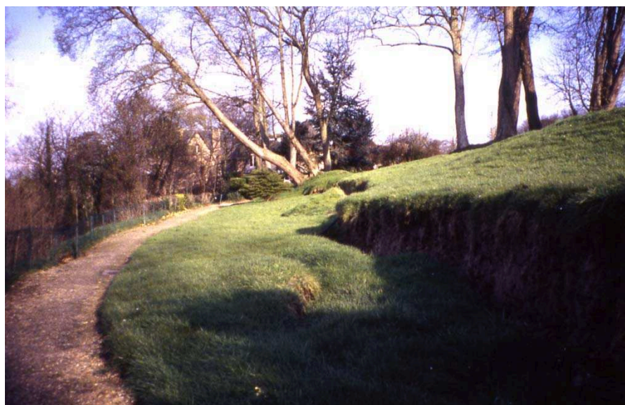
Figure 2-25. Recul de l’escarpement principal et affaissement au droit de la propriété Les Ecores lors de l’accélération de mars 1995 du glissement des Fosses du Macre à Cricqueboeuf .
