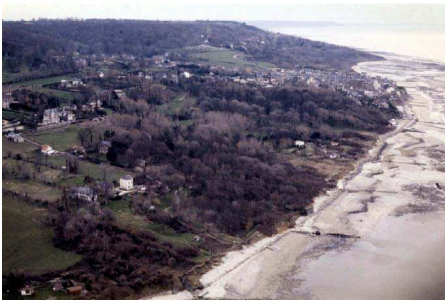
Figure 2-23. Vue aérienne des Fosses du Macre (vue vers l'ouest) suite à l'accélération de février 1988 avec au premier plan, le soulèvement de l'estran en un bourrelet discontinu.
