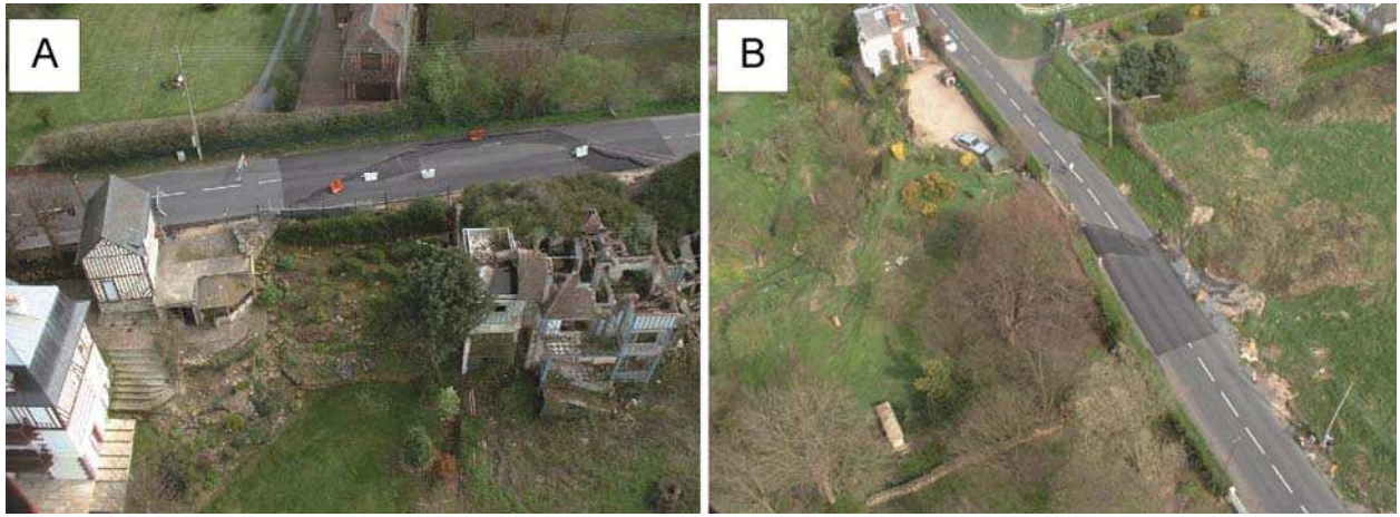
Figure 6-24. Vue aérienne des zones d'affaissement affectant la R.D. 513 au droit des villas 'Trescartes' (A) et 'Mirella' (B), lors de la crise de janvier 2001 du glissement du Cirque des Graves (Photo : DREAL, 2001).
