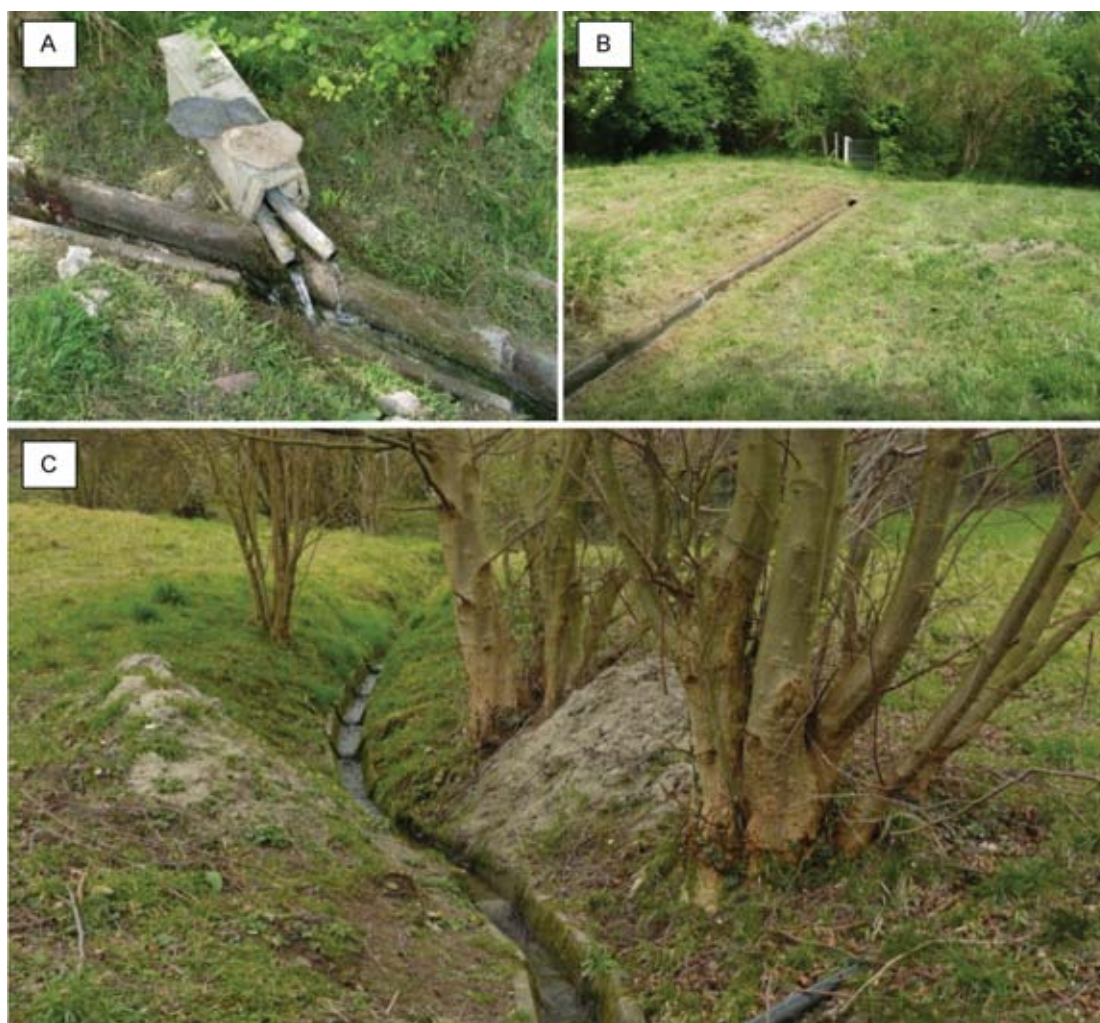
Figure 8-16. Drains 'artisansaux' permettant le drainage des eaux de subsurface en partie médiane du Cirque des Graves, jusqu'au pied du versant.
