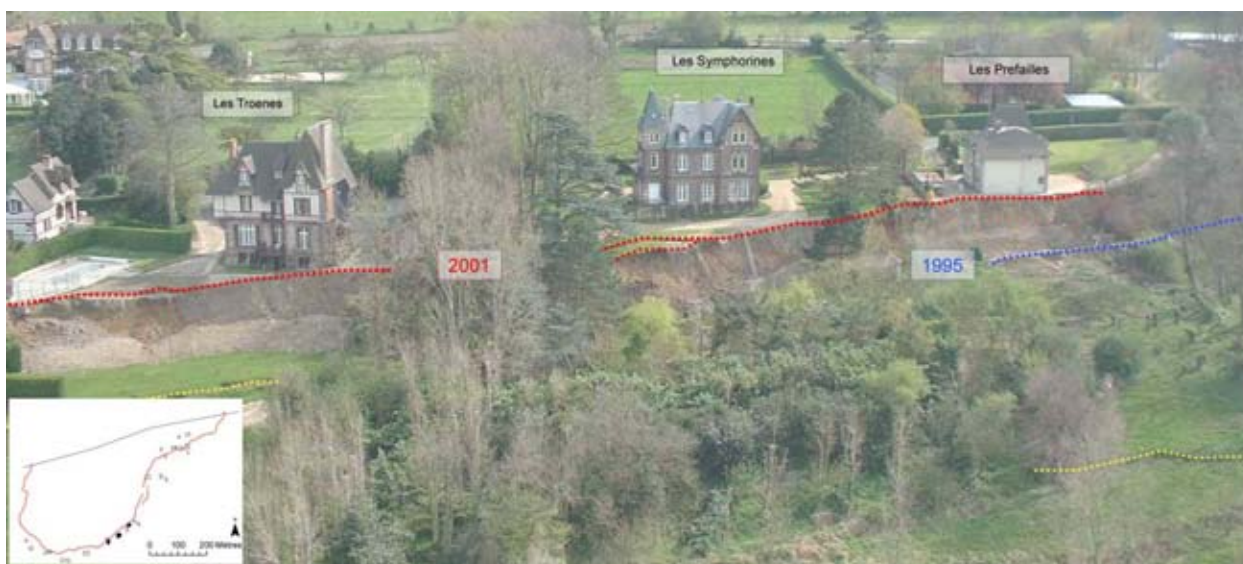
Figure 6-19. Positions de l'escarpement principal en 1995 et 2001 au droit des propriétés Les Troènes, Les Symphorines et les Préfaillies du glissement des Fosses du Macre à Cricqueboeuf (Photo : DREAL Basse-Normandie, avril 2001).
