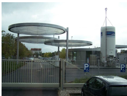
Fig. 1.7: Station service cryogénique Linde
