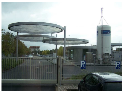
Fig. 1.7: Station service cryogénique Linde
