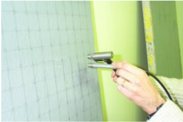
Figure 103 : Détail d'un essai par impact.
