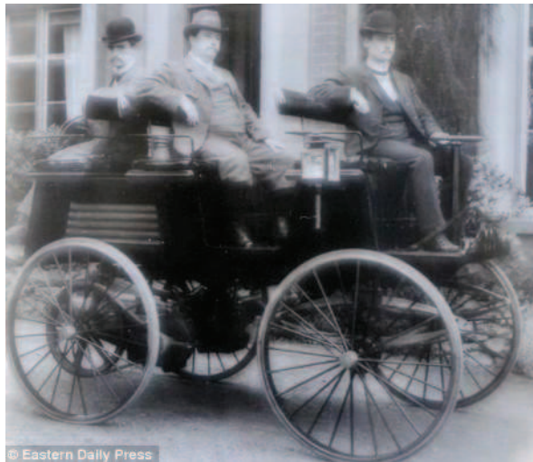
Figure 1.1 – Carriole électrique [MES07]
