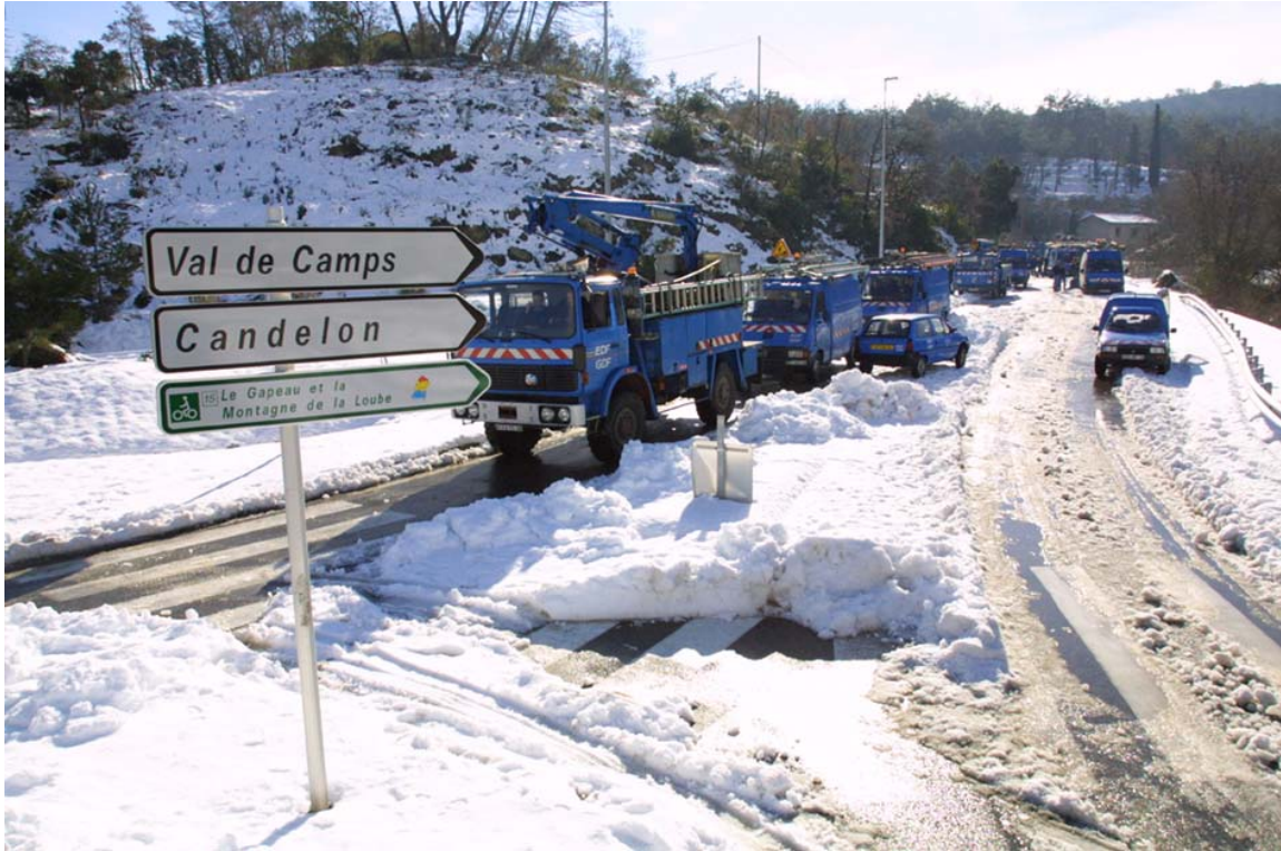
Figure 40 : Photographie de l'arrivée d'un camion grue et d'équipes de secours après le déneigement des voiries routières. (Source : Service presse ERDF).
